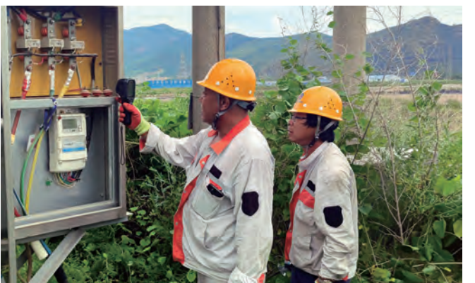
供电公司台北供电所党支部围绕“打造红色堡垒”，组织开展“喜迎二十大，隐患大排查”活动，共产党员服务队重点对 10KV 塔山线、10KV 程圩线、10KV 先锋线等主要线路设备进行特巡测温，及时消除各种隐患和薄弱环节，确保“二十大”期间电网设备安全运行。(王建)
